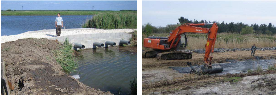
Fig. 32 : Aménagement de la prise d'eau du casier 8 et curage du canal principal (photos : Baudet ONCFS)
