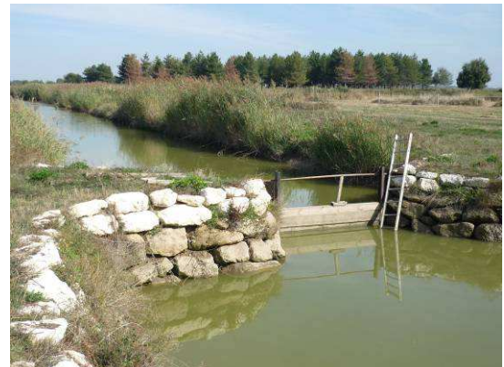
Fig. 43 : Batardeau du bassin de répartition (photo : Verdeyroux ONCFS)
