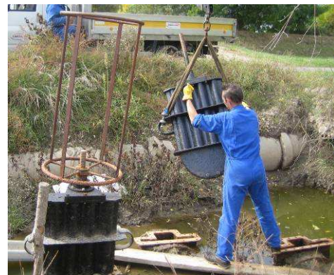
Travaux menés en 2007 (photo : Baudet ONCFS)
