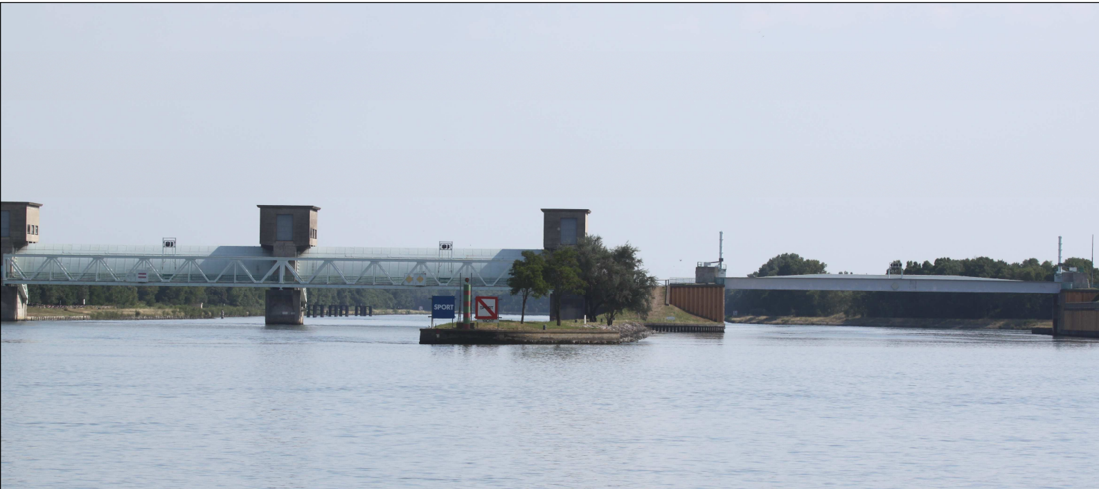
Barrage de gardes des passes navigables (© D. Roux / ONCFS).
