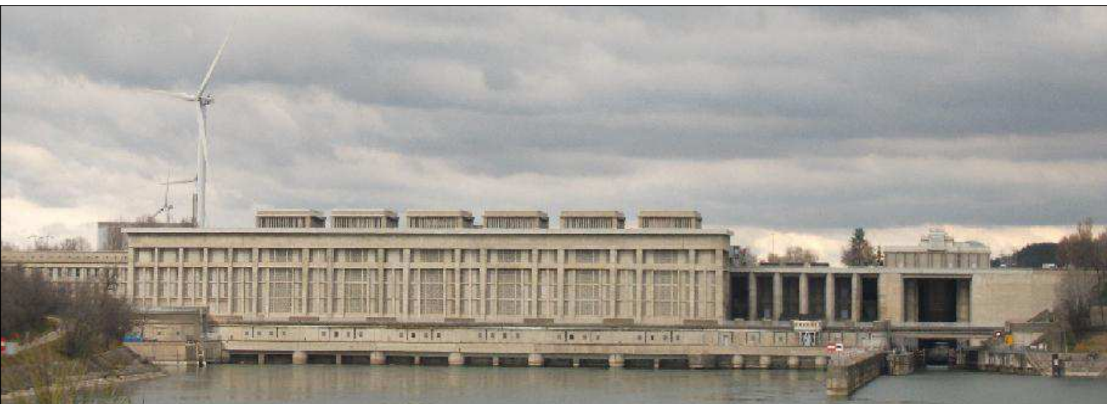
Face aval de la centrale hydroélectrique « André Blondel » à Bollène. En arrière plan, le parc éolien CN'Air (© C. Moinardeau/ONCFS).
