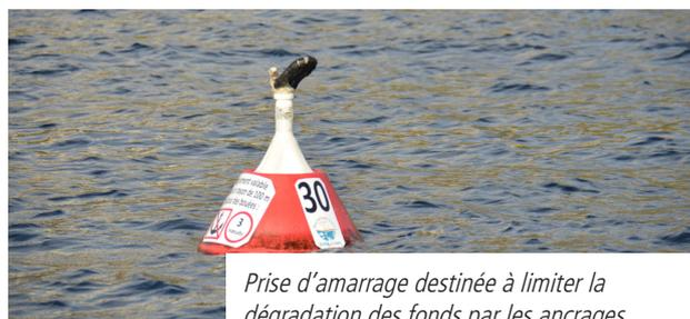
*Prise d'amarrage destinée à limiter la dégradation des fonds par les ancres.*
