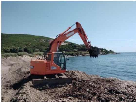
Figure 52 : Contrôle travaux banquettes © Laurent Ricquiers/OFB
