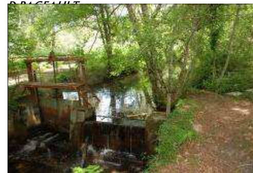
Figure 14 - Photos écluse de la Machinotte.
