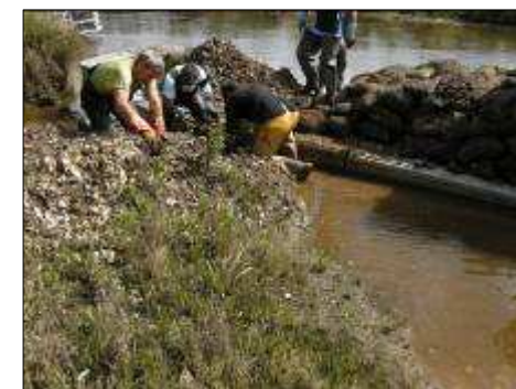
Figure 13 - Chantiers d'enlèvements de puits. J.ALLOU
