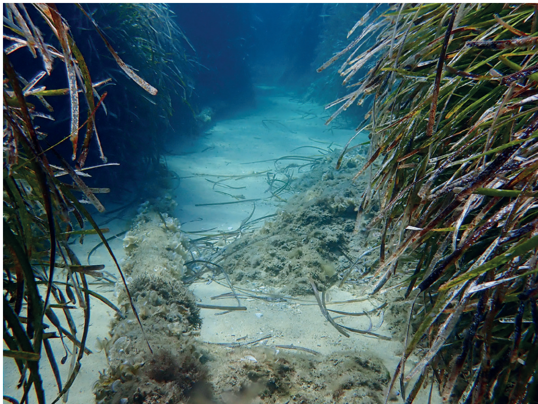
Le raccordement des câbles peut avoir un impact sur les fonds marins, notamment sur les herbiers de Posidonies
