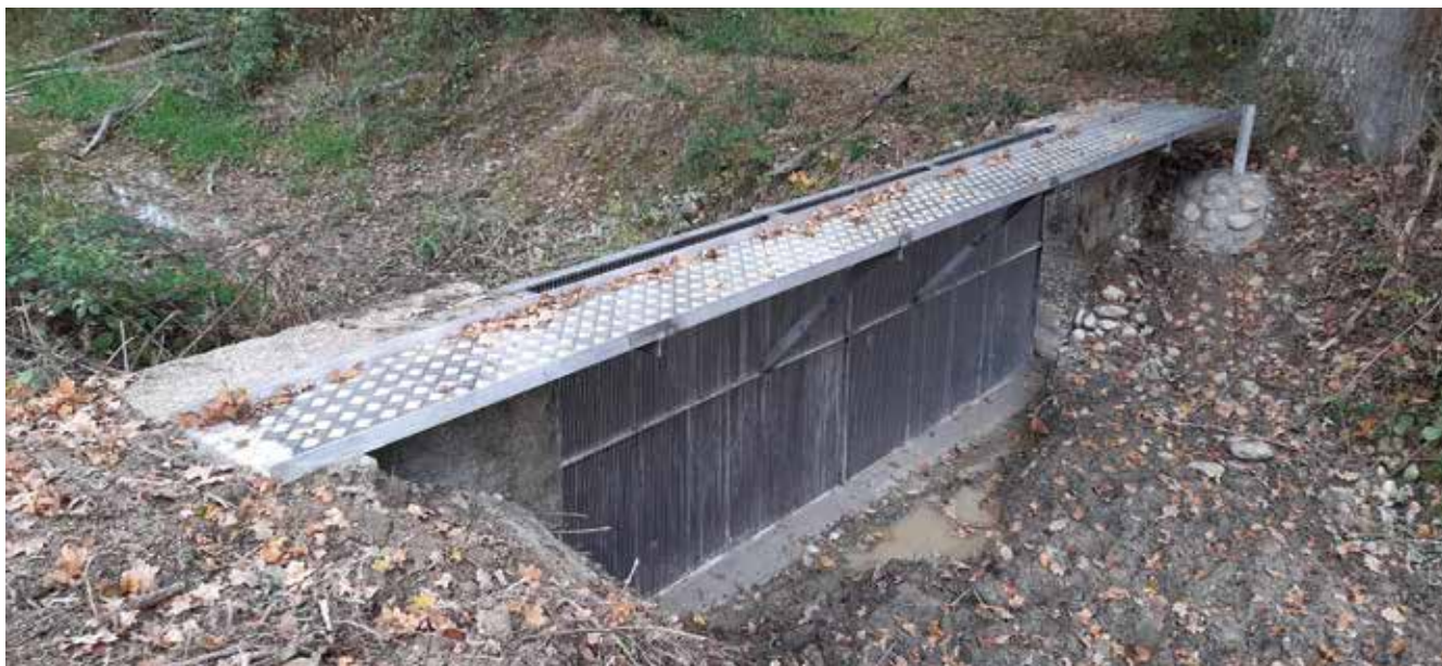
Réfection de la grille dite de la Levée sur l'étang du Grand Birieux © Maurice Benmergui / OFB
