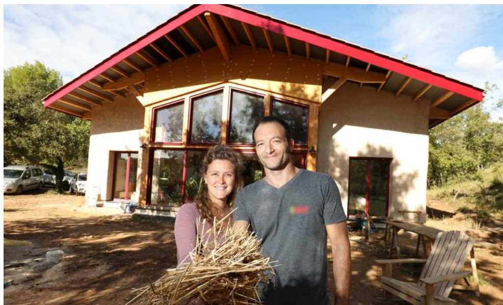
Paille, terre, pins d'Alep... Pour construire leur maison bioclimatique, Doriane et Sylvain ont utilisé des matériaux en circuit (très) court. Photo Philippe Arnassan
