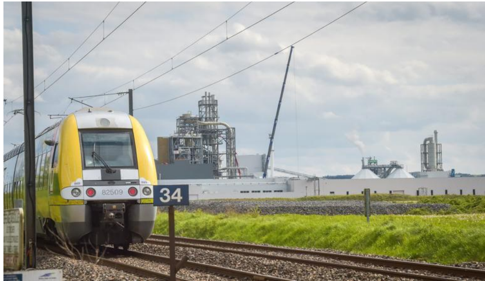
Le groupe Pavatex vient de construire une nouvelle usine de panneaux isolants en fibre de bois sur l'écoparc de Chavelot, à quelques pas de la nouvelle chaudière biomasse de Green Valley Énergie. Photo Jérôme Humbrecht
