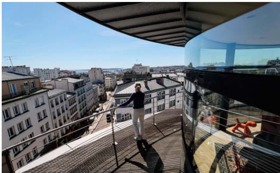
Tout en haut de la galerie commerciale de Coat-ar-Gueven, c'est un particulier qui a racheté l'appartement du quatrième étage, en 2008. Il a doublé la surface en rajoutant des pièces sur le toit. Son duplex de 380 m 2 offre une vue panoramique sur la ville. PHOTOS LIONEL LE SAUX
