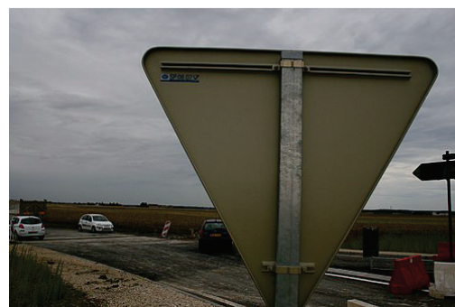
Marquage de la norme NF et de son numéro d'admission au dos d'un panneau français
