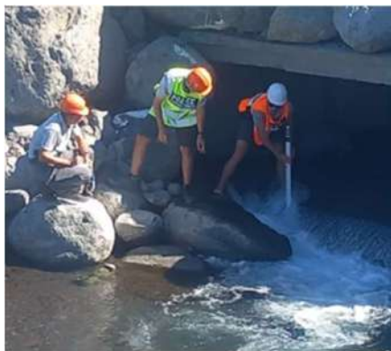
Contrôle de franchissabilité d'un ouvrage sur cours d'eau, © DR- SD 974
