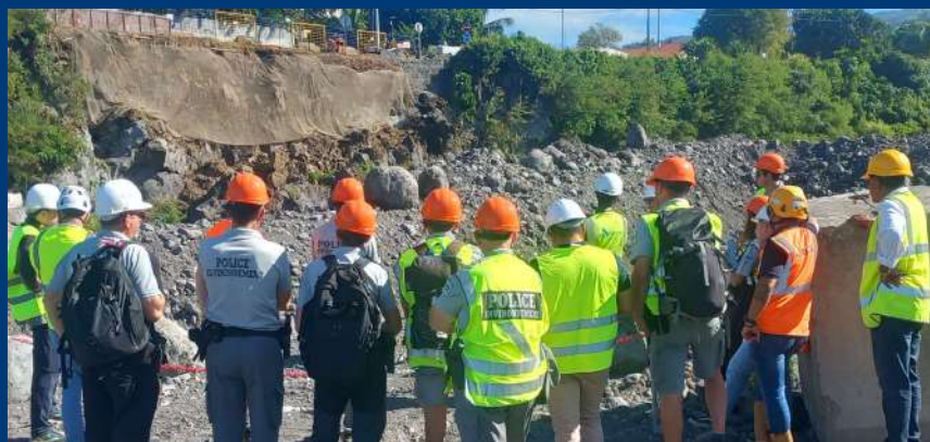
Visite d'un chantier en cours d'eau, © DR - SD 974
