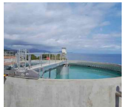
Station d'épuration de Koungou en construction © Grégoire Savourey / OFB
