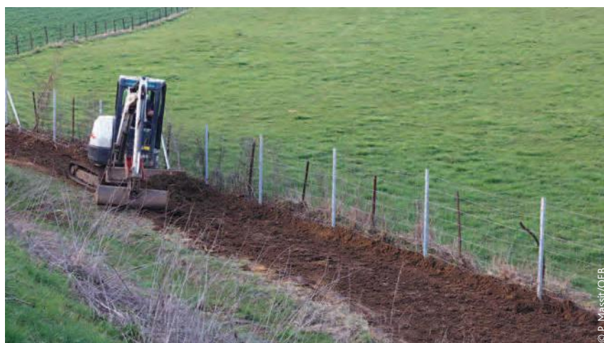
▲ Construction de la clôture dans la Meuse en mars 2019.
