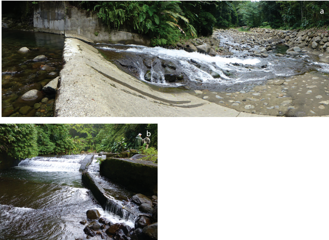
Exemples d'ouvrages complexes pouvant être décomposés en une succession d'ouvrages « simples ». (a) Ouvrage pouvant être décomposé comme un seuil à parement incliné présentant en aval un seuil en enrochements (rivière Pérou, Guadeloupe), (b) Ouvrage pouvant être décomposé comme une succession de deux seuils inclinés (rivière Saint-Louis, Guadeloupe).
