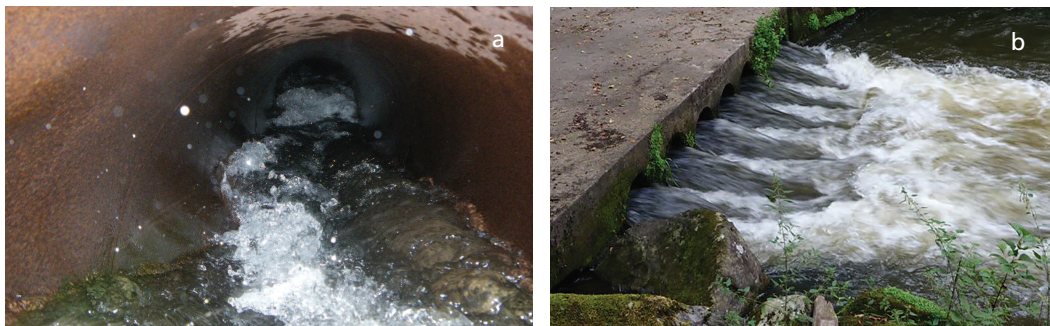
Exemples de fortes vitesses au niveau de passages busés. (a) Buse sur la rivière Saint-Étienne (La Réunion), (b) Gué sur la Maronne.
