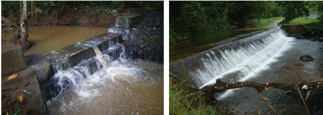
Exemples de redans au niveau de seuils inclinés. (a) Exemple de seuil avec redan (rivière Boungoumouhé, Mayotte), (b) Exemple de seuil avec redan (Rivière Blanche, Martinique)
