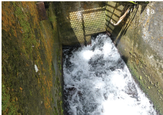
Exemple d'ouvrage complexe ne pouvant pas être décomposé en plusieurs ouvrages « simples ». Pour ce cas (c.-à-d. écoulements sous vanne en charge poursuivis par un seuil à parement incliné en aval), l'ouvrage ne peut pas être décomposé en deux ouvrages « simples ». La vitesse initiale en amont du seuil incliné est beaucoup plus importante (vitesse en sortie de vannage très forte) que dans le cas d'un seuil incliné classique sur lequel la mise en vitesse s'effectue progressivement. Cependant, une modélisation hydraulique s'avère inutile dans ce cas, puisque le passage sous la vanne est d'ores et déjà infranchissable. L'ouvrage peut donc globalement être considéré comme une barrière totale (Classe ICE = 0).
