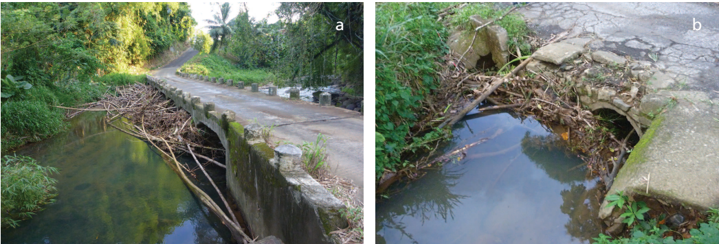
Exemples d'ouvrages fortement comblés en amont par des embâcles. (a) et (b) Ouvrages colmatés sur des rivières martiniquaises.
