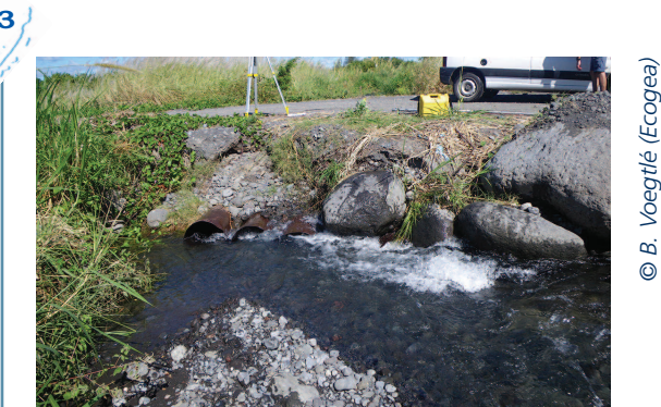
Exemple de mise en vitesses en amont d’un passage busé. Buses sur la rivière Saint-Étienne (La Réunion)
