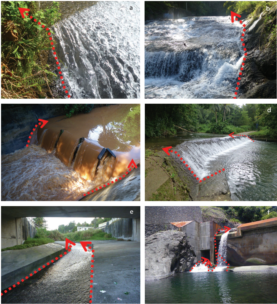
Exemples de voies de reptation potentielles à analyser pour l'anguille (matérialisées par les tirets rouges). Ces voies sont également des voies potentielles de ventousage pour les Sicydiinae ou les post-larves et juvéniles de petites espèces benthiques et des voies de marche pour les macro-crustacés (ouvrages visibles à la Martinique, à Mayotte, à La Réunion).
