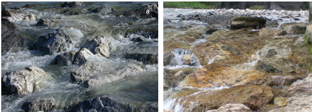
Qualité d'écoulements entre enrochements. (a) Écoulement sur un seuil en enrochements jointoyés au béton, pour une pente de 12 % : les espèces ont la possibilité de passer assez aisément dans les zones marginales à faible débit, les espaces interblocs constituant des mini-bassins, (b) Écoulement sur un seuil en enrochements pour une pente > 20 % : la présence de ressauts et de chutes locales, sans fosse d'appel entre les blocs, sont susceptibles de constituer autant de points de blocage pour le franchissement des poissons.
