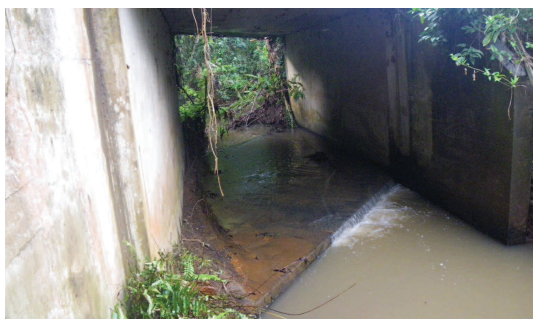
Exemple de faibles tirants d'eau au niveau d'un radier sous un pont routier. Passage Beja (Mayotte).
