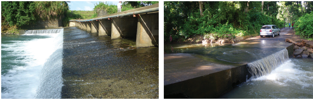
Écoulement sur un parement incliné présentant une chute aval. (a) Grande Rivière à Goyaves (Guadeloupe), (b) Passage à gué de Moala sur l'Ourovéni (Mayotte).
