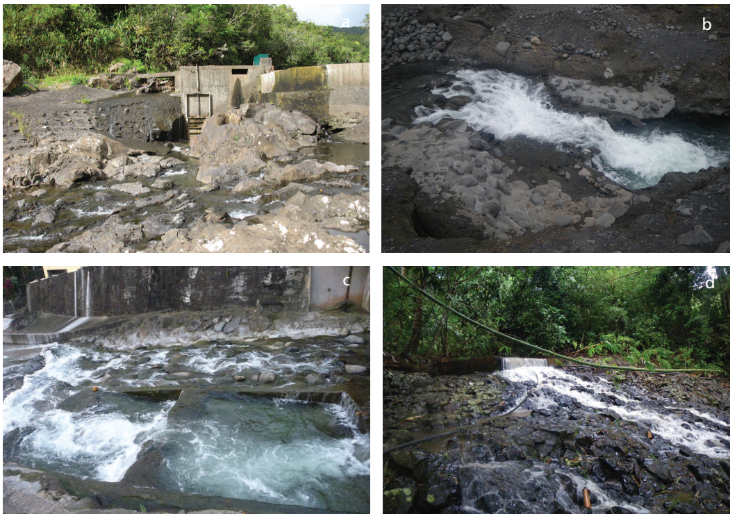
Exemples de seuils en enrochements dans les départements insulaires d'outre-mer. (a) Seuil en enrochements en aval d'un seuil de prise (Captage du Bras des Lianes, La Réunion), (b) Seuil de stabilisation en enrochements liaisonnés (rivière des Galets, La Réunion), (c) Seuil en enrochements franchissable par conception pour certaines espèces, couplé à une passe à bassins (commune de Grand'Rivière, Martinique), (d) Écoulements sur la roche naturelle pouvant s'apparenter à un seuil en enrochements (Mayotte).
