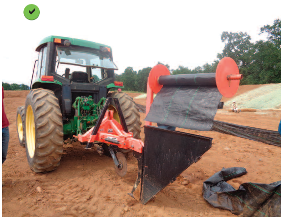
Dispositif d'installation automatique des barrières de rétention.
