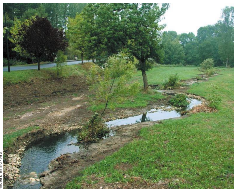
La restauration doit permettre le rétablissement de la dynamique fluviale. Un exemple de cours d'eau reméandré : l'Orfeuill après travaux (Indre-et-Loire).
