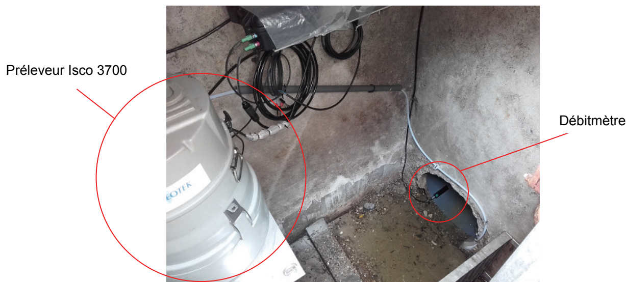
Figure 28. Débitmètre positionné dans la canalisation. © SIBA.
