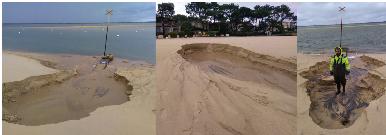
Figure 47. Affaissement de la plage suite à l'effondrement de la canalisation de rejet des eaux pluviales du passe-débit de Montaut ; à droite, agent du SIBA vivant un moment de solitude.
