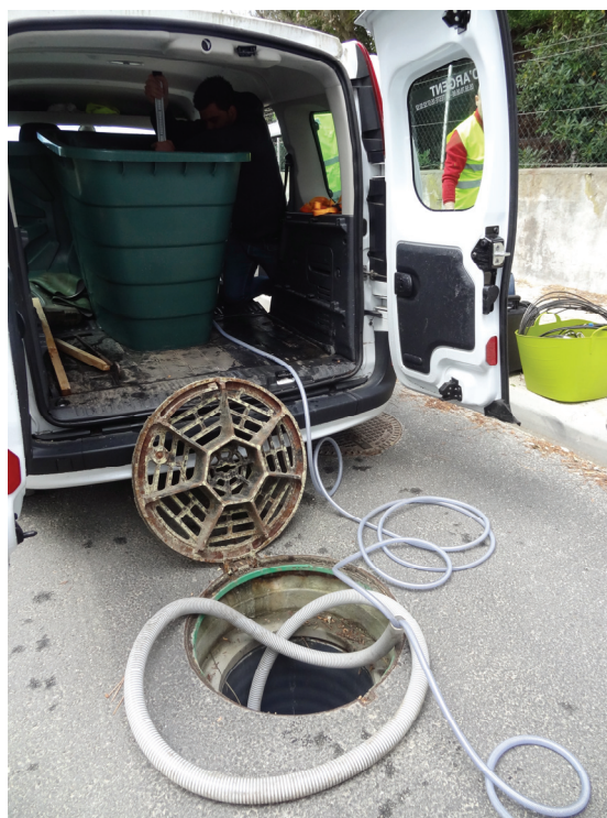
Figure 91. Injection de la saumure dans les événements.
