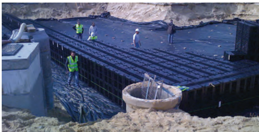
Figure 8. Commune de Lège-Cap Ferret. Bassin d'infiltration d'un volume de 770 m 3 pour la suppression d'un rejet d'eaux pluviales vers le milieu récepteur (en zone sensible de baignade et d'activité ostréicole), 2014 © SIBA.
