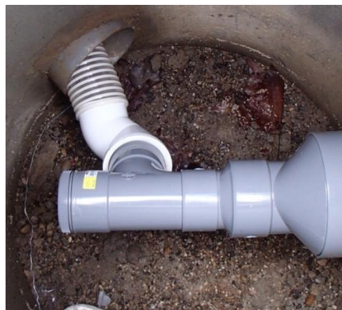
Figure A4- 8 : Connexion refaite dans le regard
