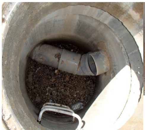
Figure A4- 8 : Connexion refaite dans le regard
