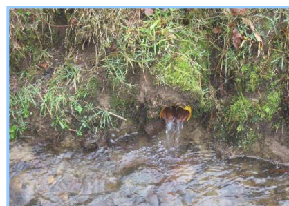
Drain primaire amenant directement l'eau au réseau hydrographique. Photo : Irstea
